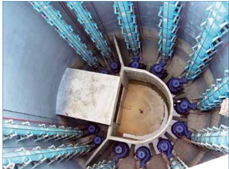
Рис. 5.11e: Готовая насосная станция KRT с предварительно рассчитанной конструкцией.
