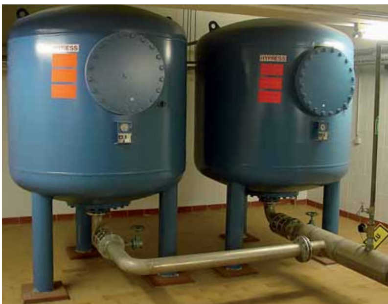
Рис. 8.1.1-с: Мембранный воздушный бак (аккумулятор)
