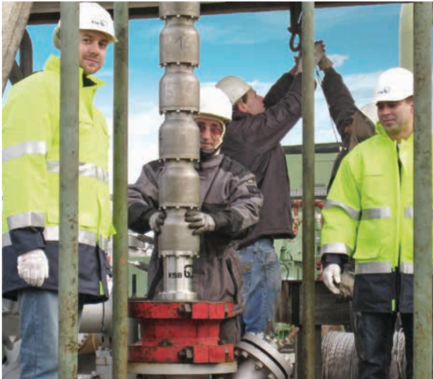
Montage vor Ort
