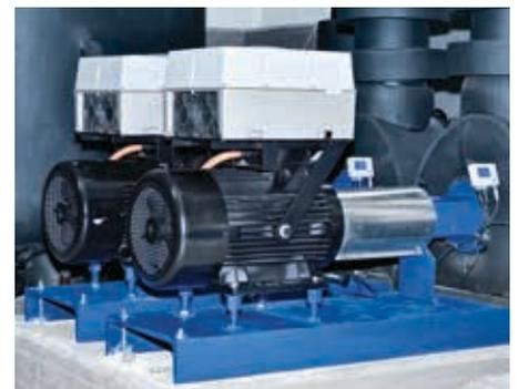
2 Etanorm PumpDrive-Pumpen als Dauerläufer mit hocheffizienten KSB SuPremE®-IE5-Motoren\*.
