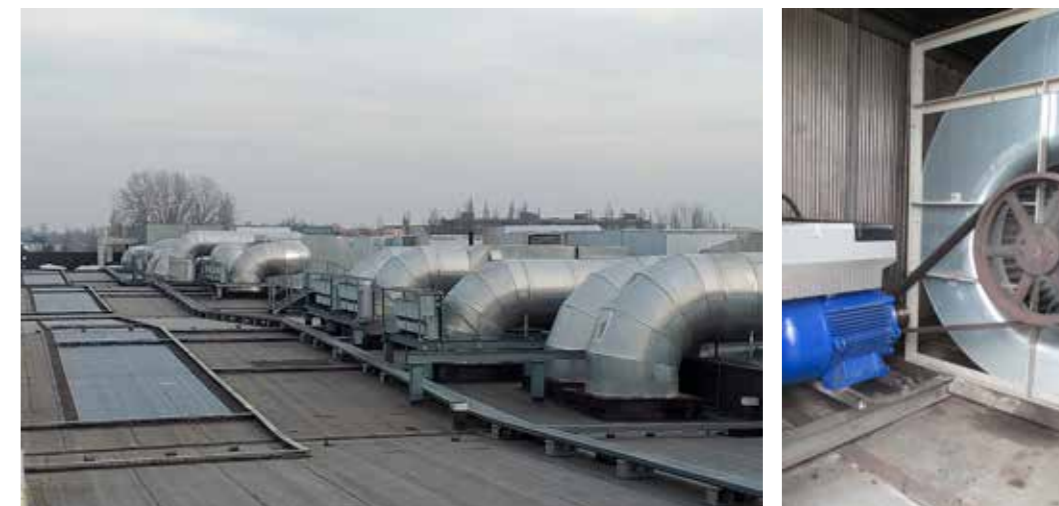
UTA equipaggiati di motori SuPremE e convertitori a bordo motore FlexiMova mm presso stabilimenti Coop Alleanza 3.0
