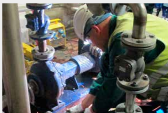
Lavori di efficientamento energetico presso uno stabilimento Galbani con un risparmio di energia del 39%.
