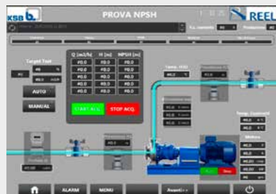
Sistema di supervisione e acquisizione dati per banco prova pompe.
