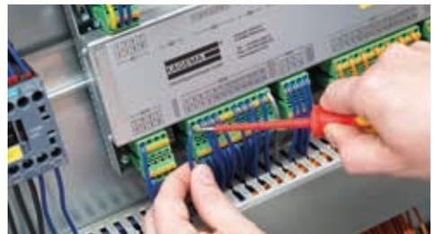
Einbau der KAGEMA-Steuerung in Schaltanlage eines Diesel-Pumpenaggregates
