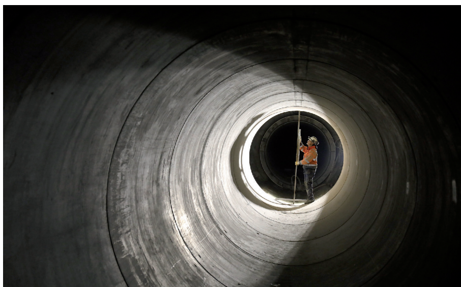
Der Abwasserkanal verläuft bis zu 40 Meter unter der Erdoberfläche.
