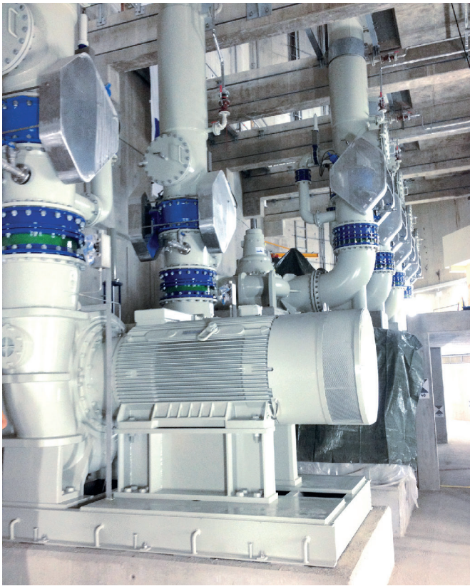
Herz der Pumpwerke sind Pumpen von KSB, die die Abwässer wieder nach oben befördern.
