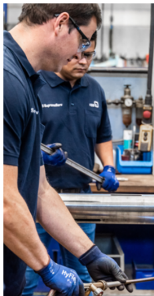
Démontage en atelier
