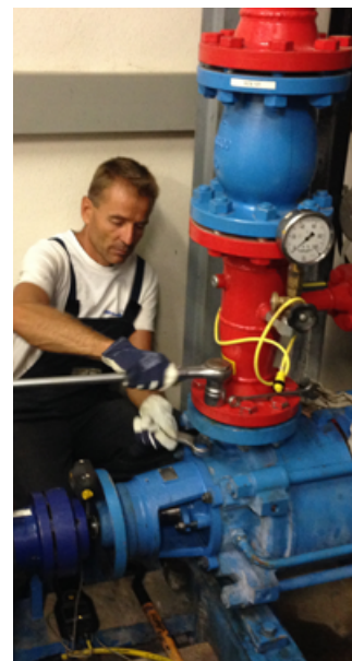
Démontage sur site
