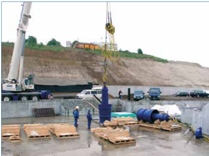
Abb. 2: Montage einer Tauchmotorpumpe mit Mobilkran
