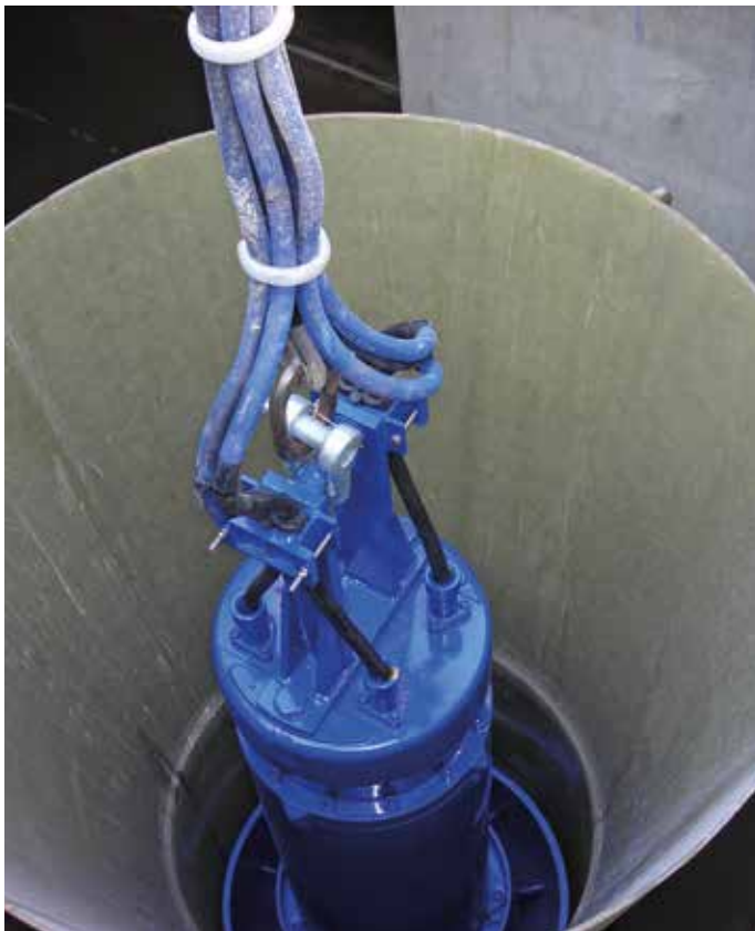
Abb. 86: Einlassen einer Amacan in das Schachtrohr
