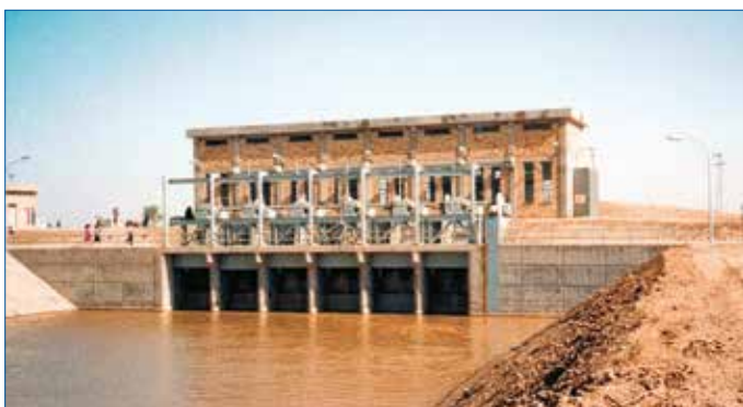
Abb. 3: Pumpstation mit Gebäude
