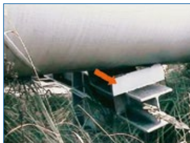
Illustration 1-b : Appui détruit (profilé en fer I de 200 mm durablement déformé)
