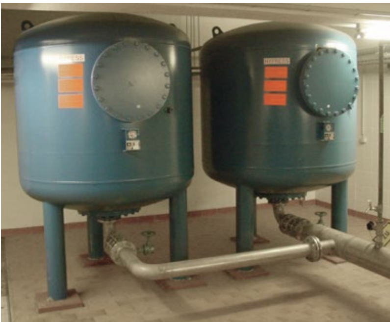
Illustration 8.1.1-c : Réservoir à vessie
