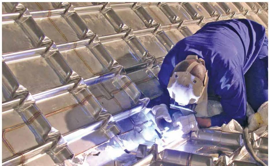
Soudure de pointage et installation de panneaux Mark III
