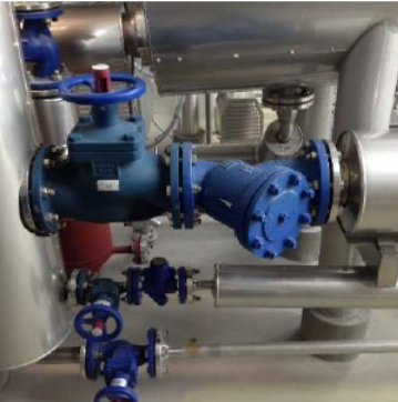
Photo : Régulation du débit au moyen d'une vanne...
