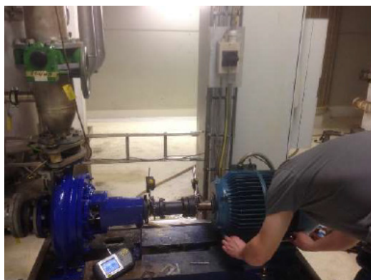
Photo : Alignement d'une pompe, à effectuer nécessairement au moyen d'un appareil laser
