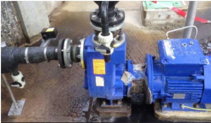
Pompe auto-amorçante (veuillez observer que le côté aspiration se
